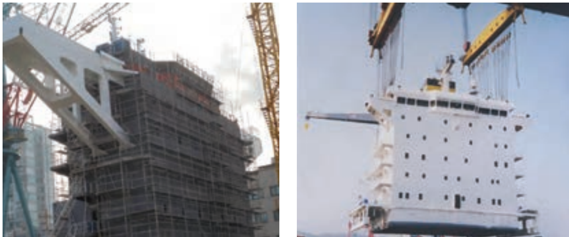
شکل ۱۶- ساختمان محل استراحت خدمه و پل فرماندهی
